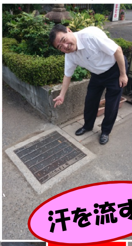
7月 道路排水修理 …美園/上野田
