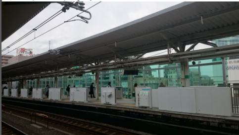
ホームドアが設置された浦和駅 も要望して参ります。
