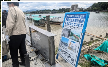
桂川治水工事
